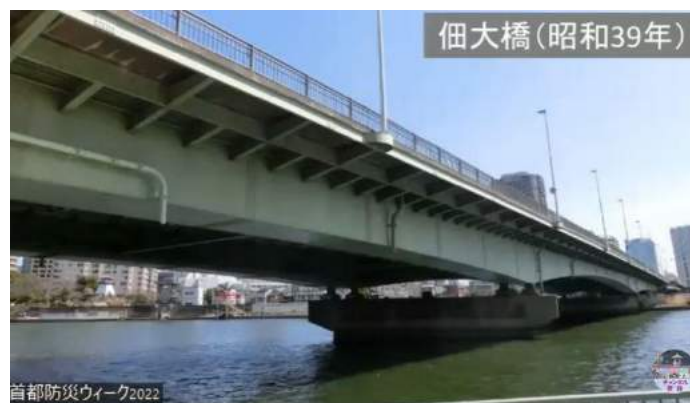
佃大橋 当時の最先端の橋
