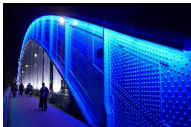
リベットを使用 永代橋の景観的ポイント
