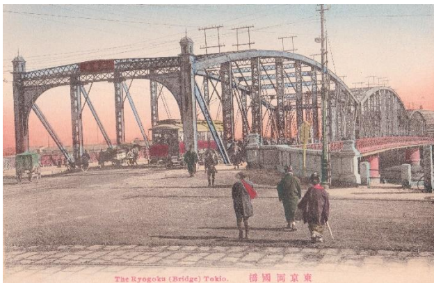
写真5 1912年に架橋された新大橋
