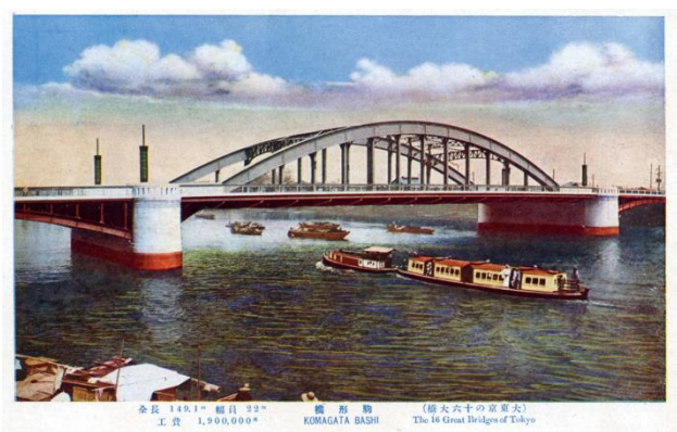
写真 13 震災復興で新設された駒形橋
