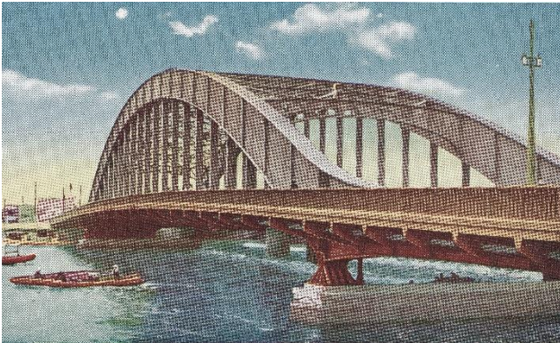
写真 10 震災復興で架け替えられた永代橋
