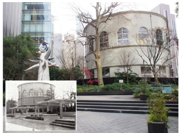
図11 現在の数寄屋橋公園と震災復旧直後の公園の写真[工事画報社(1931)]。建物は泰明小学校の校舎
