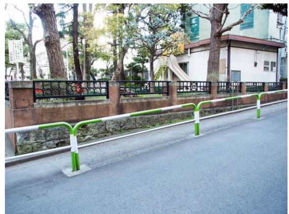
図 2 道路面に接する部分の低い鉄柵 (元町公園)
