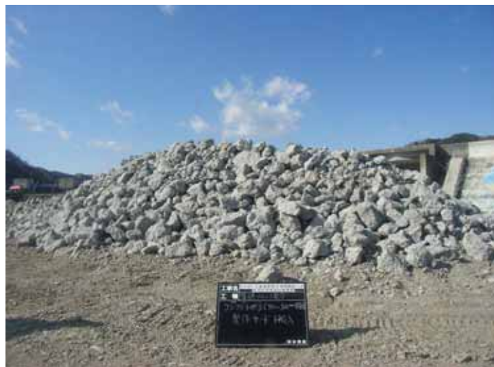
図 3.2 ブレーカーやニブラで粗割りしたコンクリートがら
