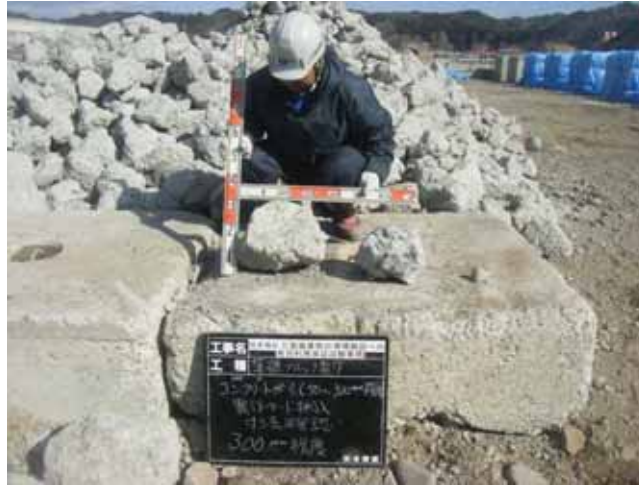
図 3.3 粗割りしたコンクリートがら (粒径 300mm)
