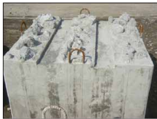
天端面にはコンブ科の海藻類が着生しやすいようにコンクリートがらで大きな突起を形成し、アワビが生息しやすいように溝を形成
