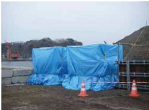
打設後の保温養生(レンタン設置)
