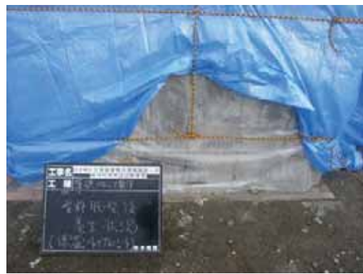
脱枠後のシート養生(保温シート+ブルーシート)
